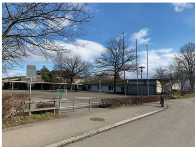
Blick von Benglenstrasse nach Osten zum Pausenplatz
