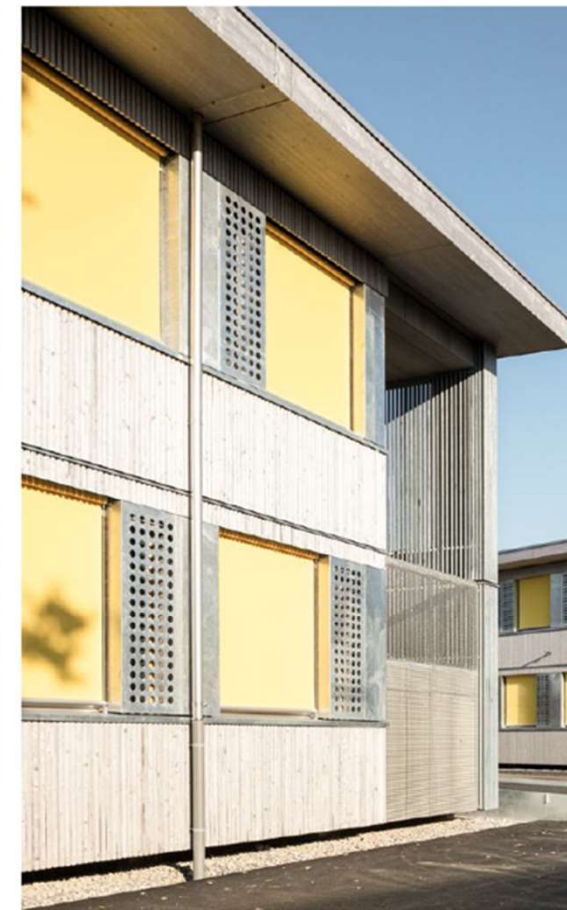
Schulraumprovisorium Bern Brünnen
